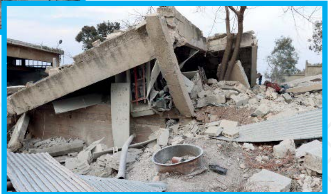
İstasyonun basar alan binaları.
