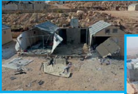
Saldırılarda hasar gören sivil yerleşim yerleri
