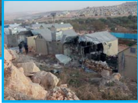
Saldırılarda hasar gören sivil yerleşim yerleri
